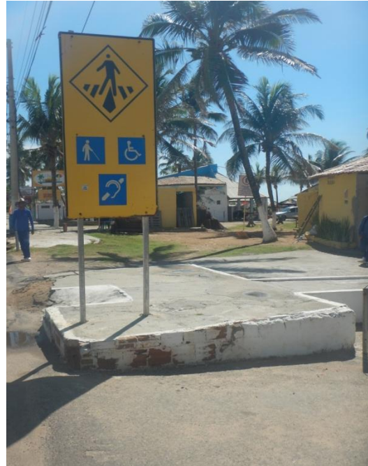
Figura 32: Rampa de Acesso
