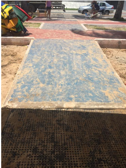
Figura 24: Rampa de acesso
